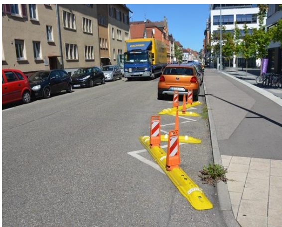
Abbildung 11: Beispiel für eine provisorische Gehwegnase; Skizze der Gehwegnase mit Schleppkurve
